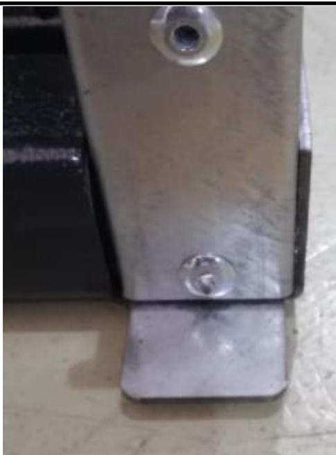
**Рис. 18. Присоединение к внешнему контуру заземления (фрагмент)**
